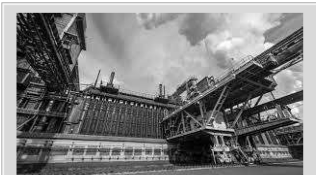
Рис. 1 Коксова батарея з технологією трамбування вугільної шихти
